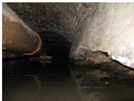
Podemletá pravobřežní opěra mostu M7
