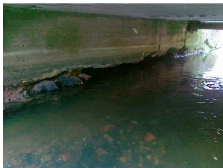
Podemletá levobřežní opěra mostu M5
